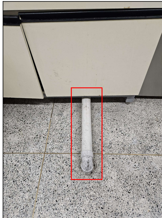
배수배관 철거 후 마감
