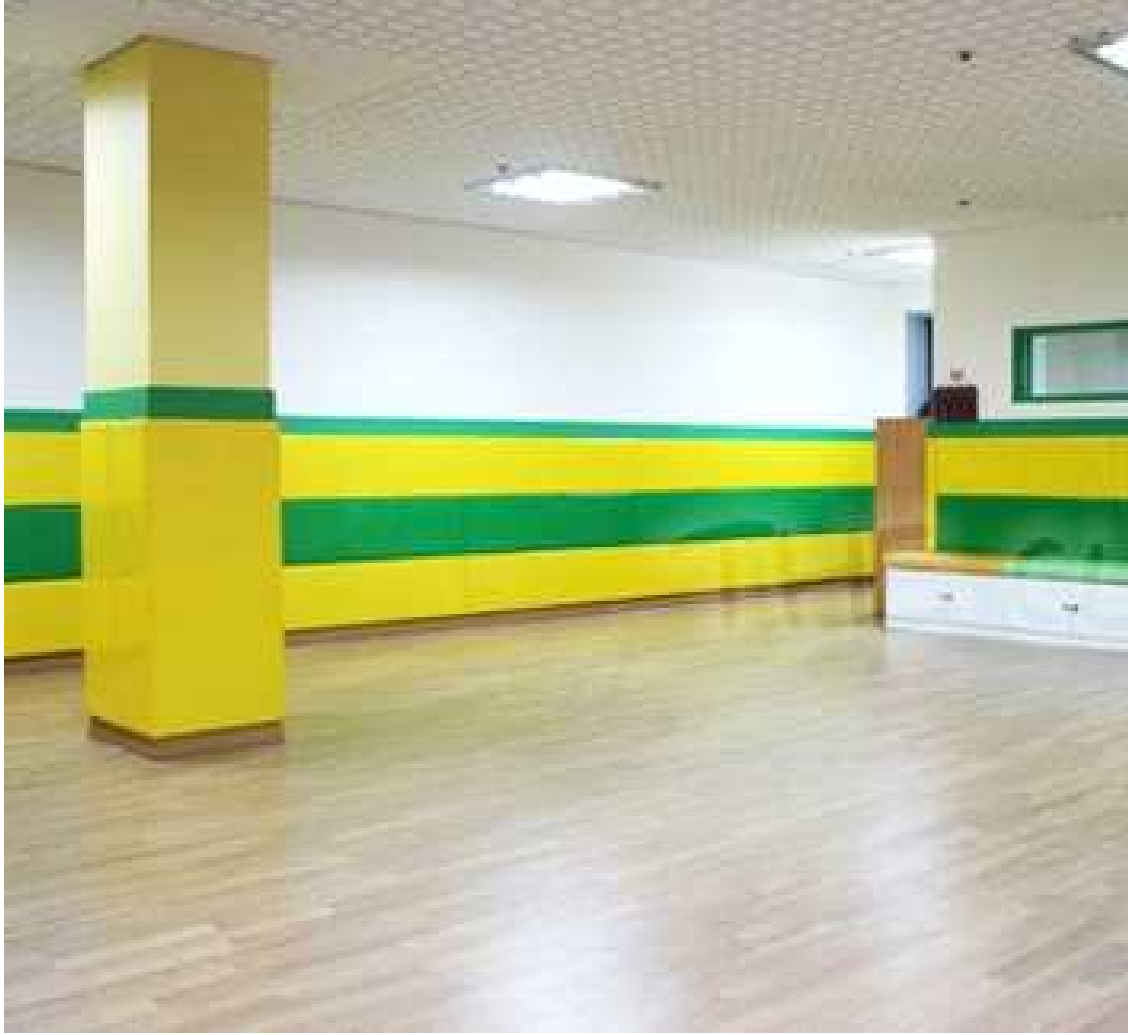
참고자료 - 벽체 및 기둥 보호쿠션 시공사례임.
