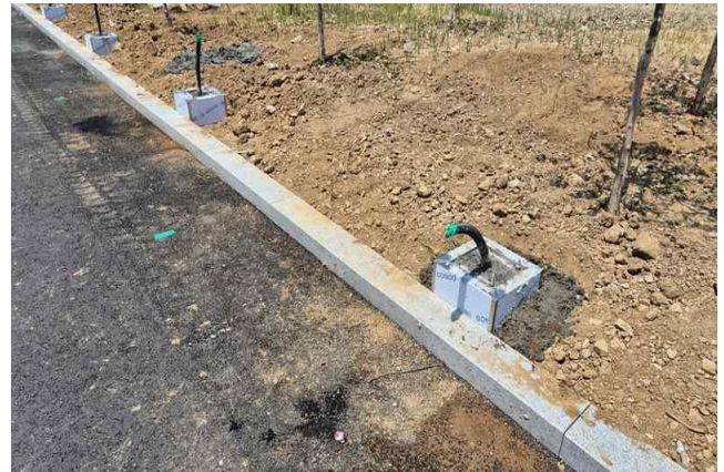
<완속 기초 공사 예시>
