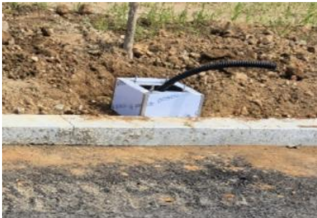
<완속 기초 공사 예시>
